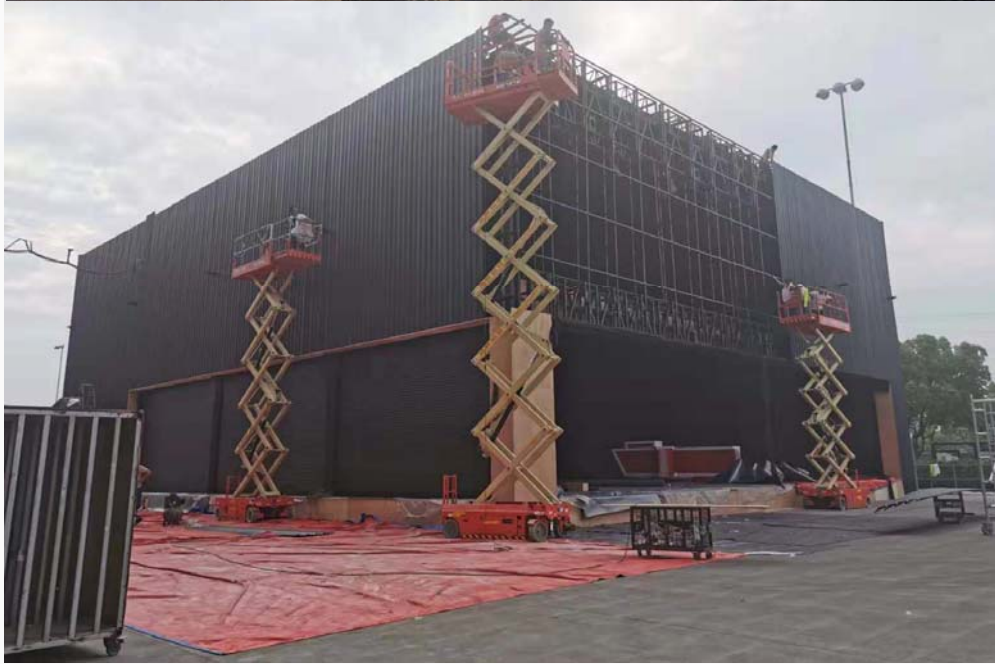
某德资品牌户外发布活动，钢铝结构。 钢柱+铝truss整体吊装抬升顶棚（2019）
