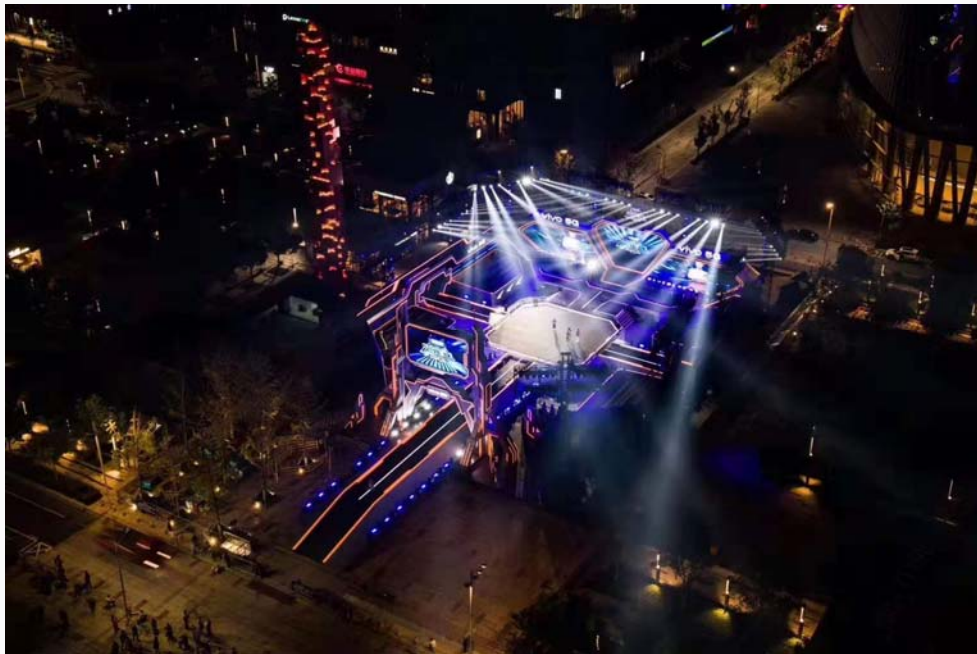
户外大型综艺节目外景结构搭建
