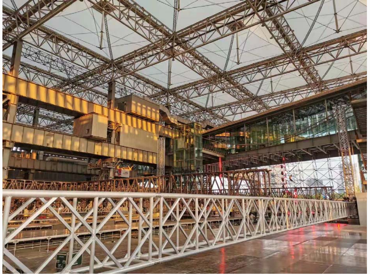
中国船舶馆43m*33m大跨无柱空间时尚秀场结构搭建
